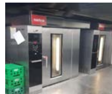
성심당 본점 로터리오븐 설치
