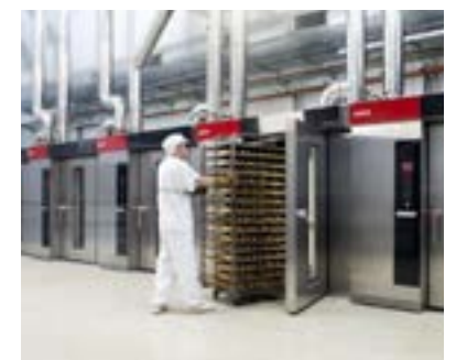
스넥공장 로터리오븐 설치
